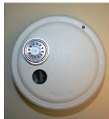
Détecteurs de fumée
